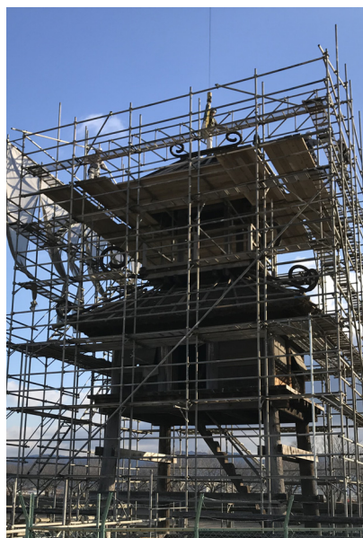
▲修繕工事中の復元楼閣
