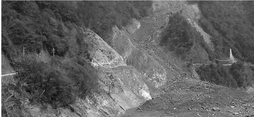
▲土砂崩れで寸断された道路
