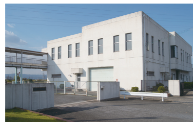
浄化センター
