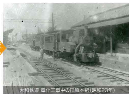
大和鉄道 電化工事中の田原本駅(昭和23年)
