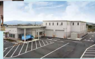
清掃センター(中継施設)
