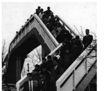
昭和42年 鍵に歩道橋完成
