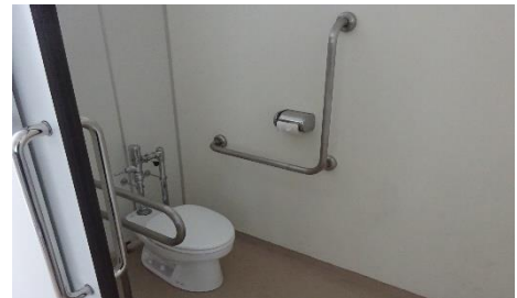
図3-5 多目的トイレ
