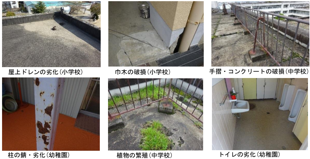
図2-9：現地調査の状況
