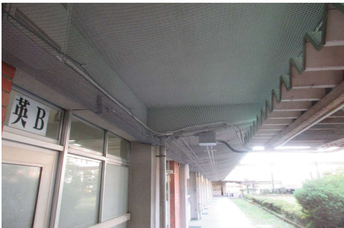
(剥落防止ネット)
