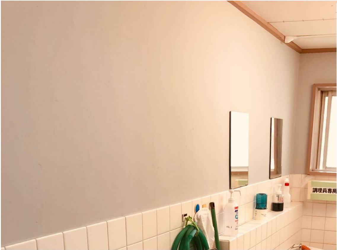
(2号棟 1階便所壁改修)
