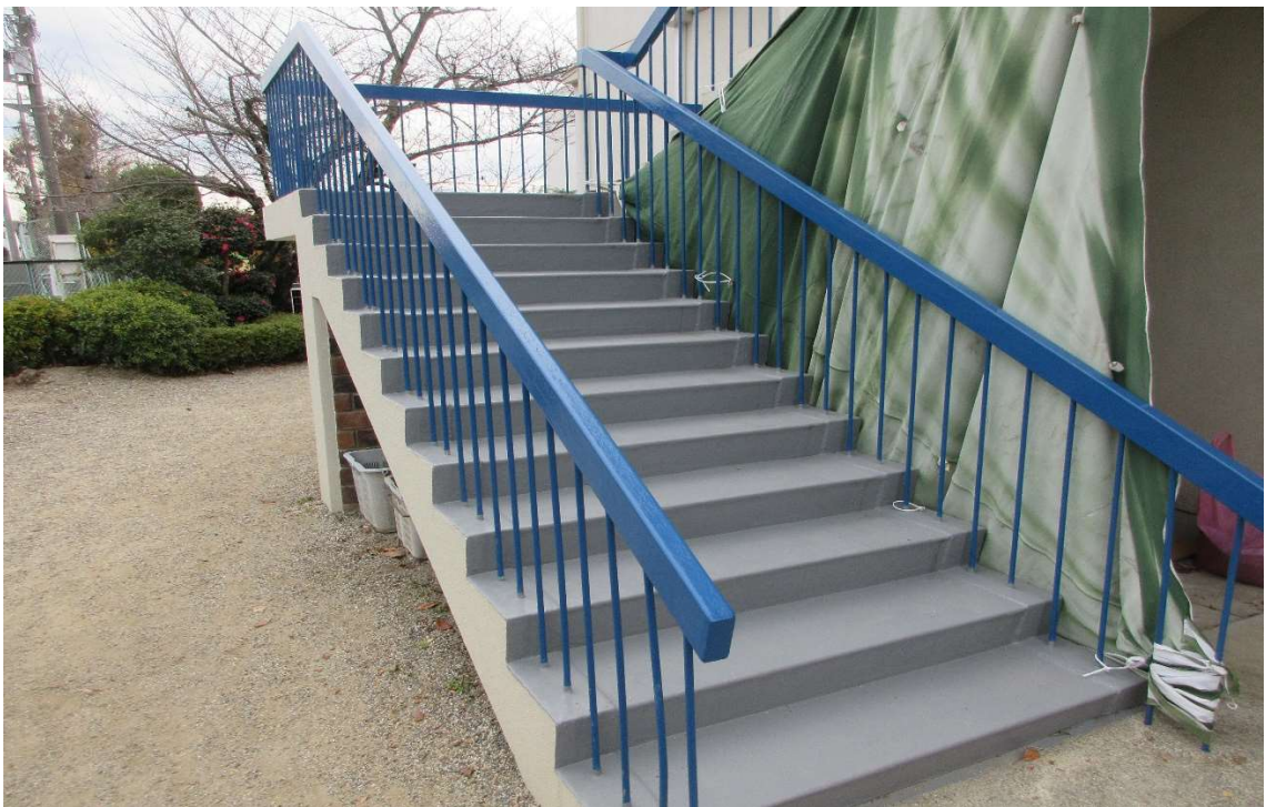
(1号棟 東側屋外階段改修)
