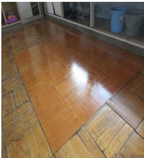
(美術室 床劣化部分張替)
