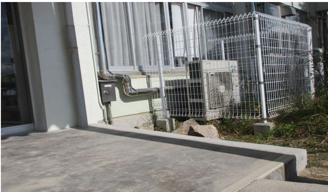
(昇降口前の石積壁撤去)
