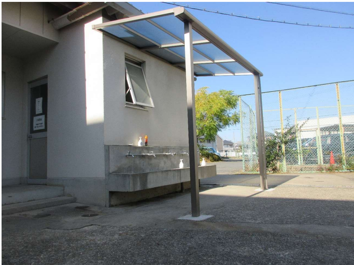
(2号棟 1階手洗い場の屋根設置)
