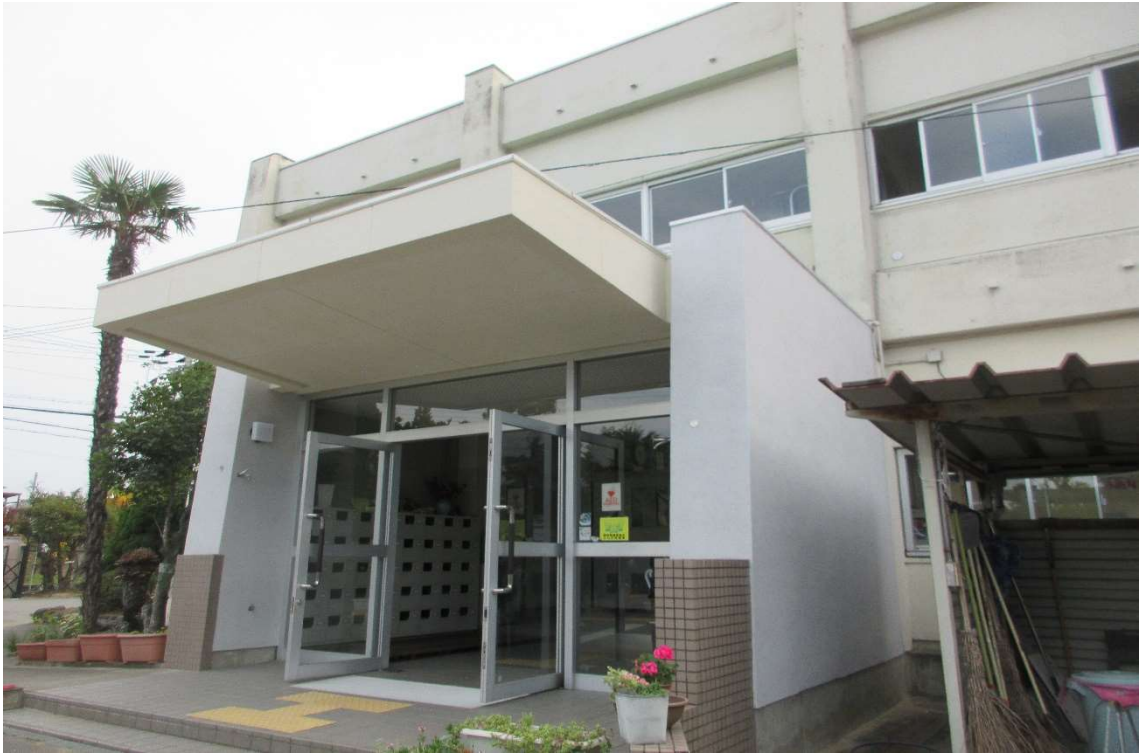
(1階玄関廻り塗装、補修)
