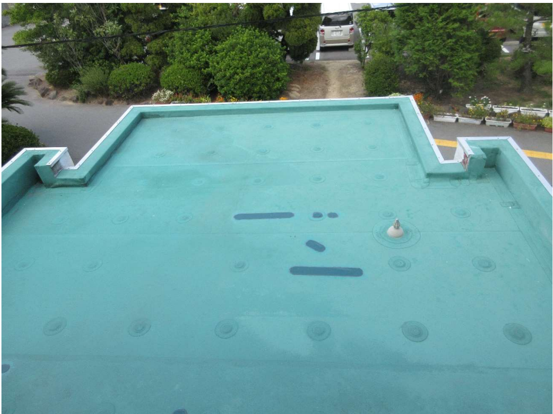
(防水破損部分補修)
