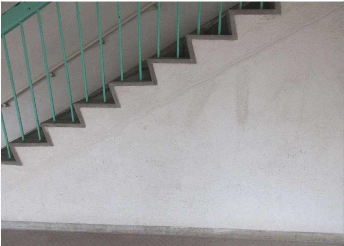
(1,3号棟 階段改修)
