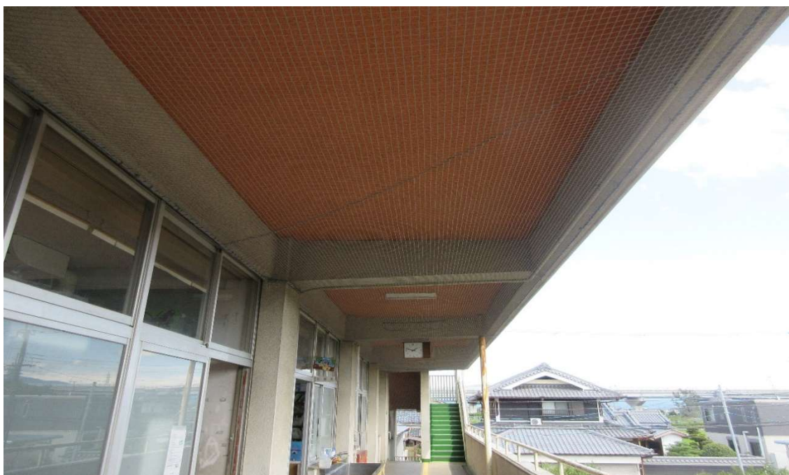
(剥落防止ネット)
