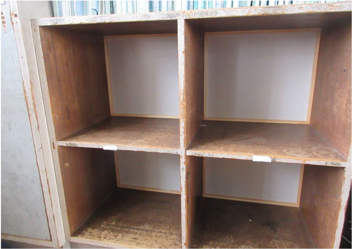
(9号棟 2階ロッカー改修)
