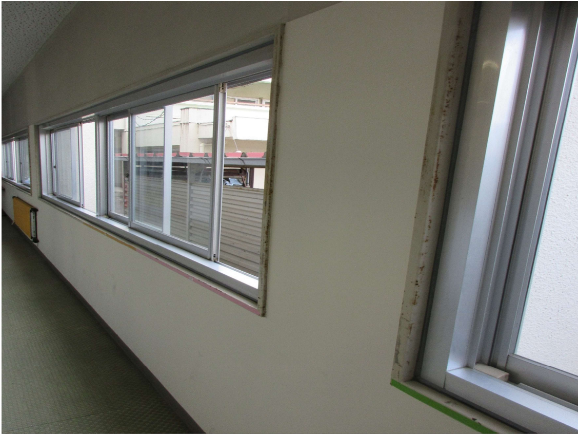
(1号棟 東棟 1、2階内壁クラック改修)
