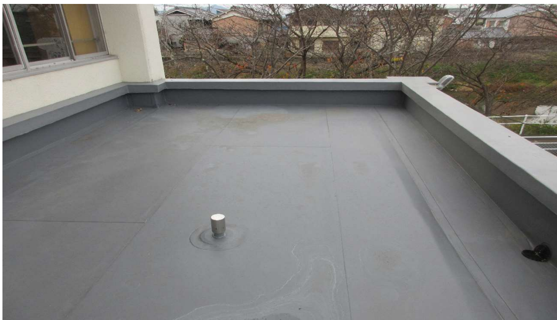
(9号棟 1階屋根防水改修)
