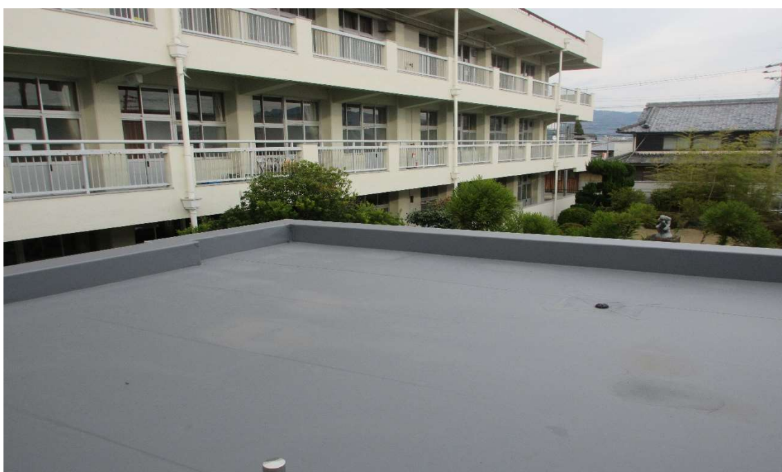
(11号棟 1階屋根防水改修)
