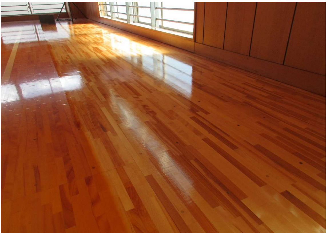
(剣道場 フローリング劣化部分張替)
