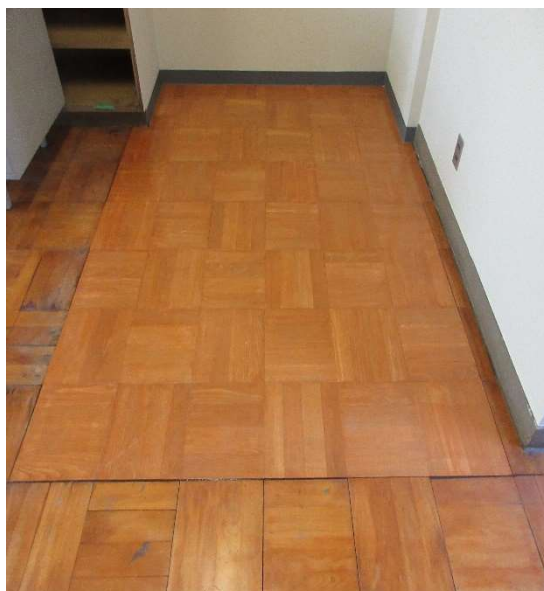
(美術準備室 床劣化部分張替)
