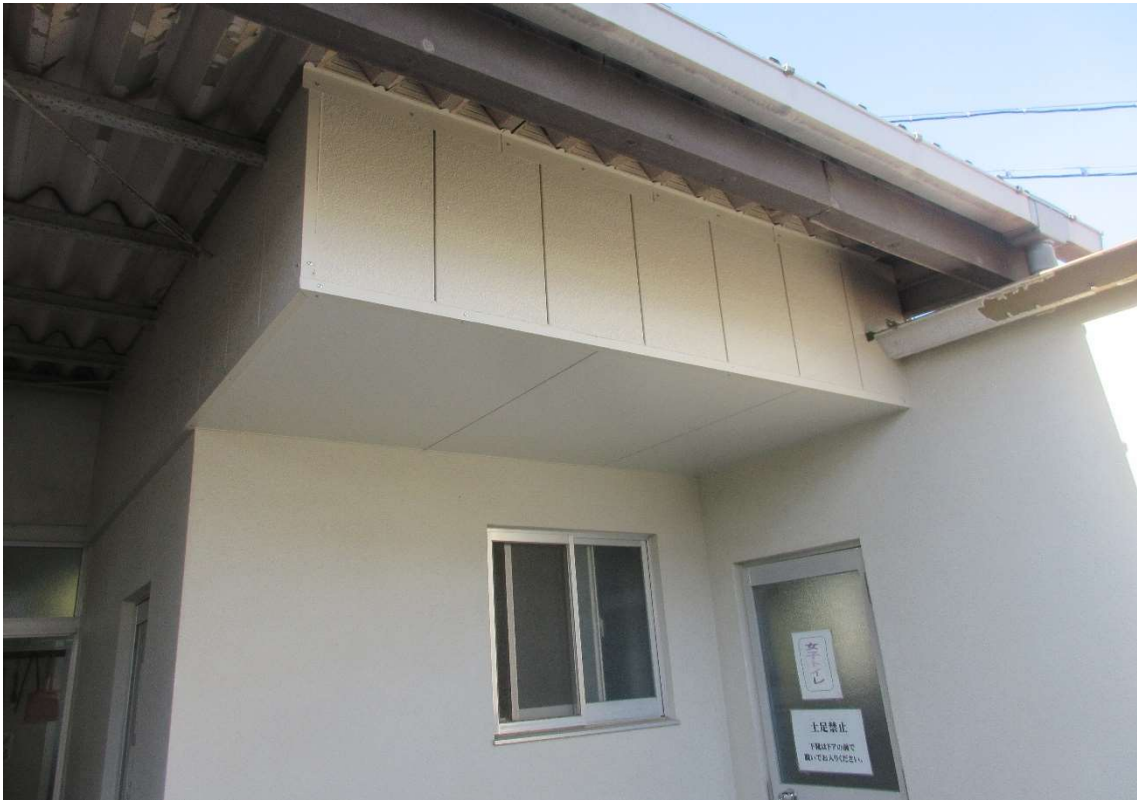
(1階職員便所の外壁・軒天改修)
