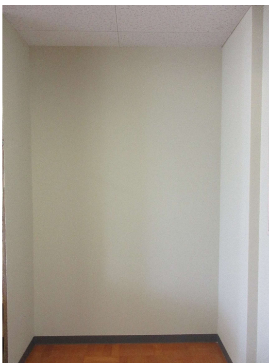
(美術準備室 天井張替及び壁造作)
