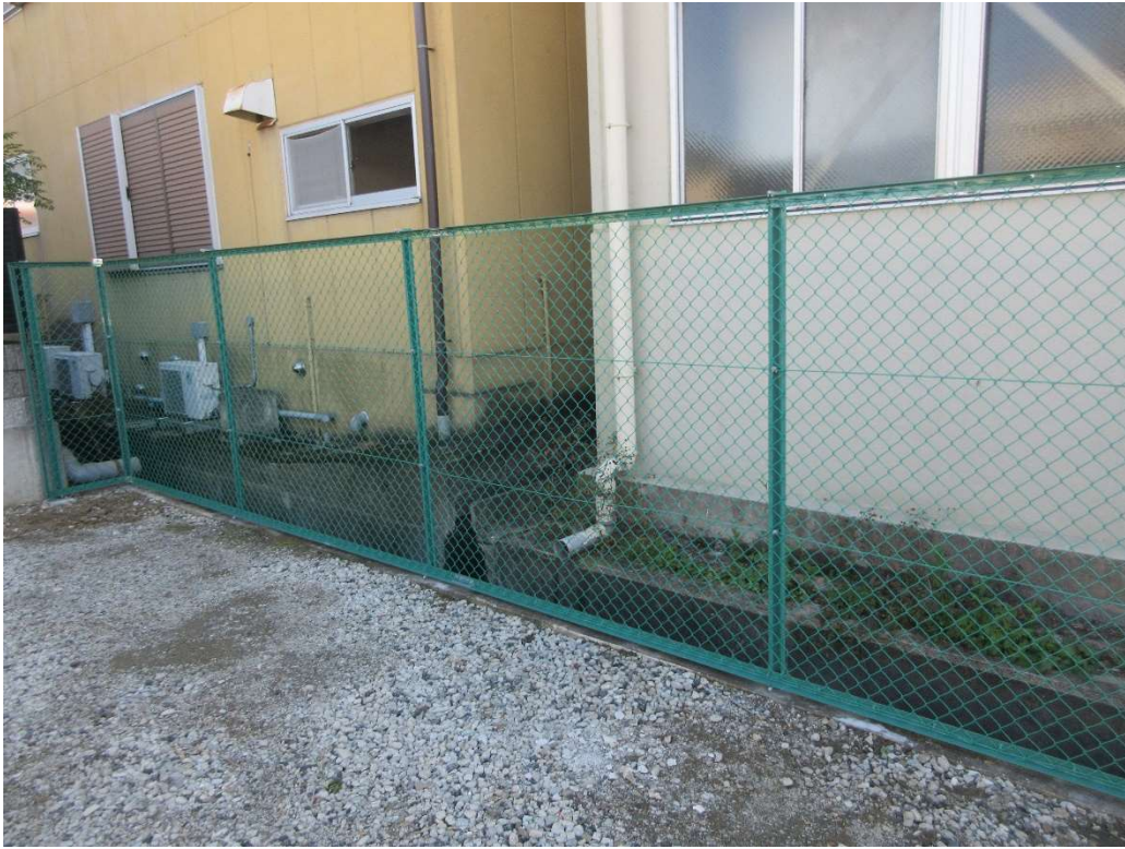
(フェンス設置)
