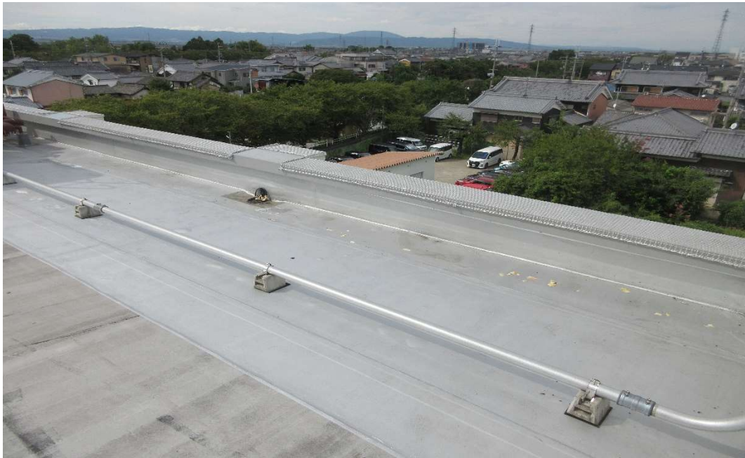
(パラペット改修)
