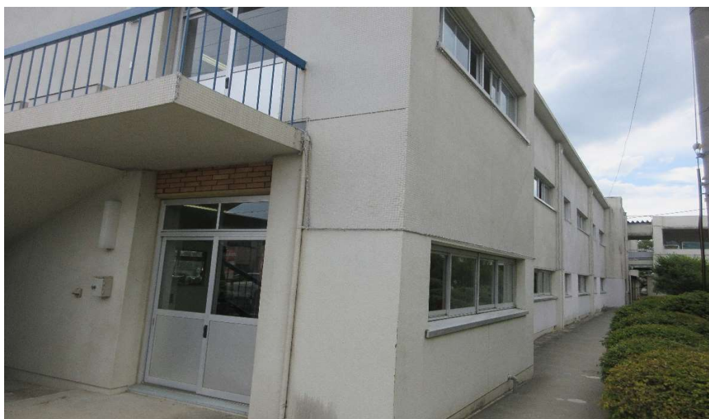
(剥落防止ネット)
