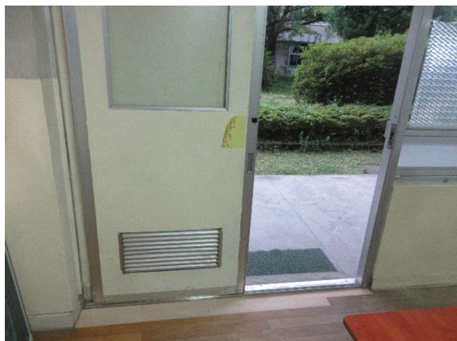
(青空教室引き戸修繕)
