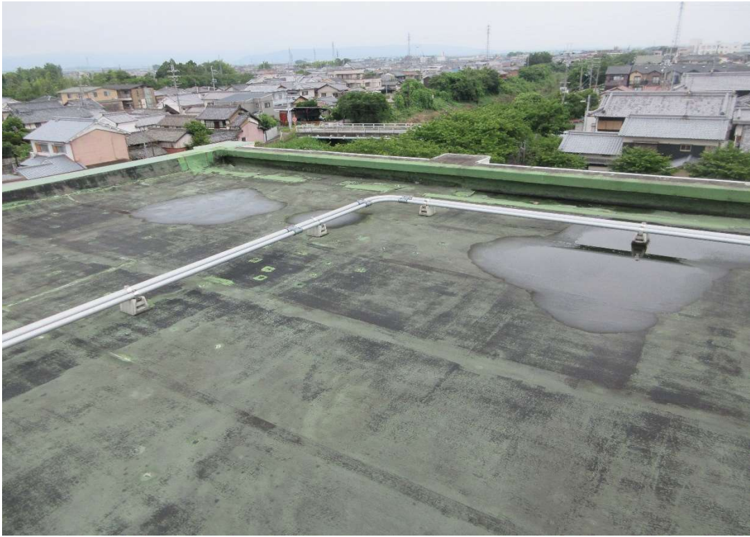
(屋上防水改修前)
