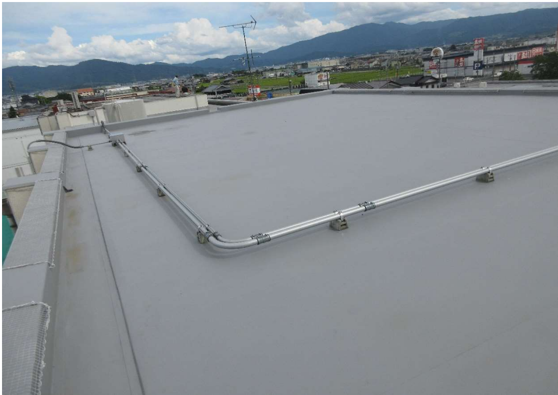
(屋上防水改修後)
