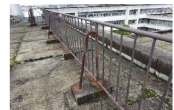
手摺の錆・コンクリートの破損
