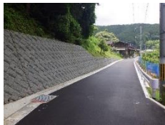
町道道路改良工事
