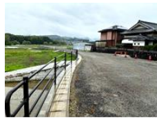
町道新設工事
