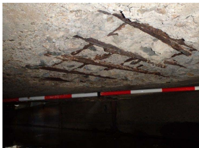
写真9 契約手順 B での発注が可能な RC 床版の損傷事例写真
