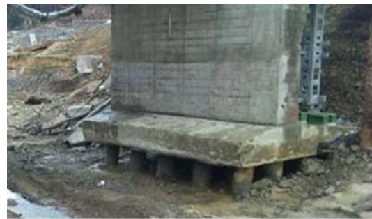
写真5 橋脚の洗掘 (洗掘深さ、沈下、傾斜計測 等)
