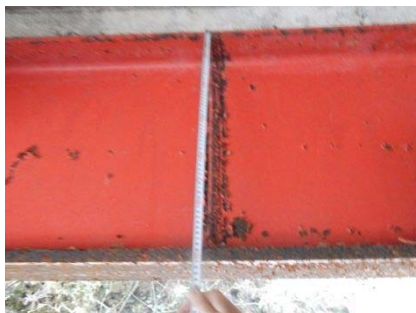
写真7 耐力評価、上部工反力の算出 (部材の構造寸法測定 等)
