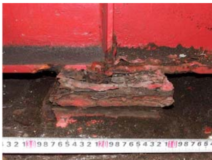
写真6 腐食した支承の取替え (沓周りの寸法確認 等)
