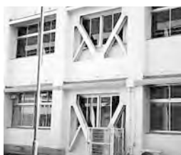
▲耐震工事が行われた北小学校南館
