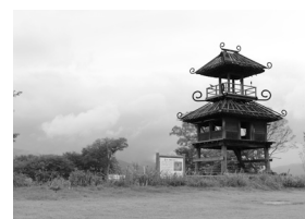
▲整備工事が進む唐古・鍵 遺跡史跡公園
