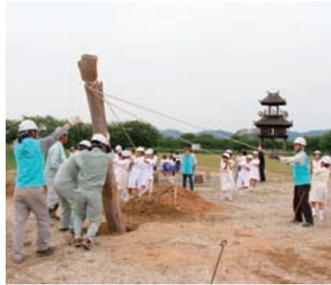
▲力を合わせて穴の中に柱を立てる
