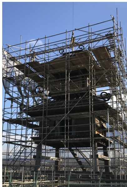
▲修繕工事中の復元楼閣
