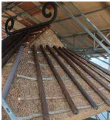
▲修繕された屋根
