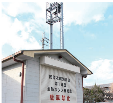
▲田原本町消防団の消防ポンプ器具庫。6分団それぞれに設置されており、火災などの際は、ここからポンプ車が出動します
