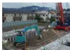
建設中の貯留施設
