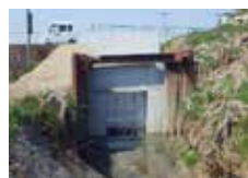
逆流防止樋門
