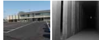
▲町社会福祉協議会駐車場地下貯留施設。雨水などをためることで、内水氾濫を抑制します
