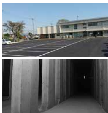
社会福祉協議会駐車場地下貯留施設
