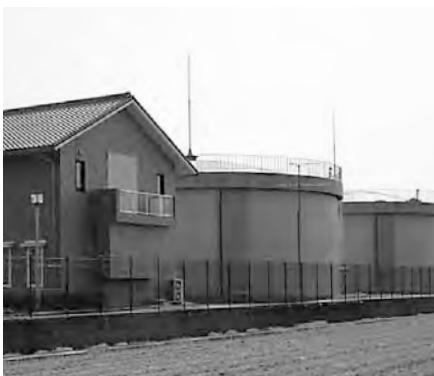
▲町配水場（伊与戸）
