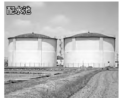
配水池 飲めるように処理された水をためておきます。
