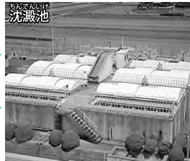
沈澱池 地下水を受け入れ、水の量を計測し、消毒剤滅菌します。
