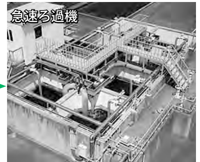
急速ろ過機 飲める水になるまで細かくろ過します。
