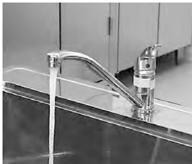
町内の家庭や学校などに配水されます。
