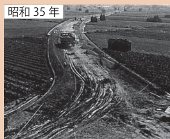
昭和35年 県道桜井田原本線工事中の様子 （大和鉄道廃線跡）
