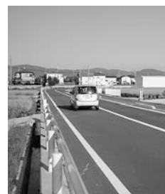
▲ 3 月 29 日に開通した宮古 25 号線
