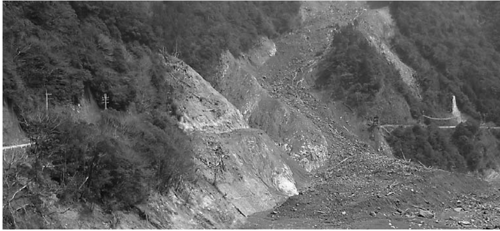
▲土砂崩れで寸断された道路
