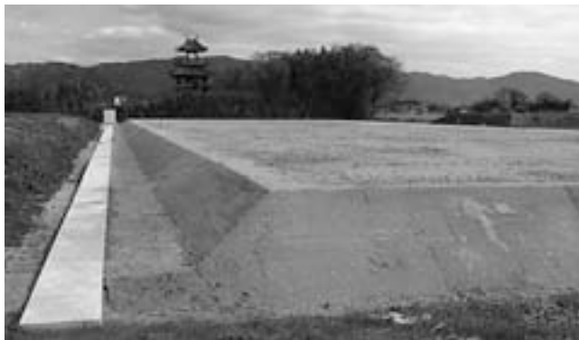
▲工事が進む唐古・鍵遺跡
