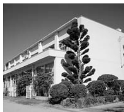
▲耐震工事が行われた南小学校南館
