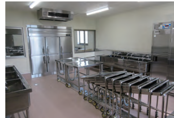
下処理室 食材の下処理を行う部屋です。下処理後の食材はカウンターを通して調理室へ受け渡しを行います。
