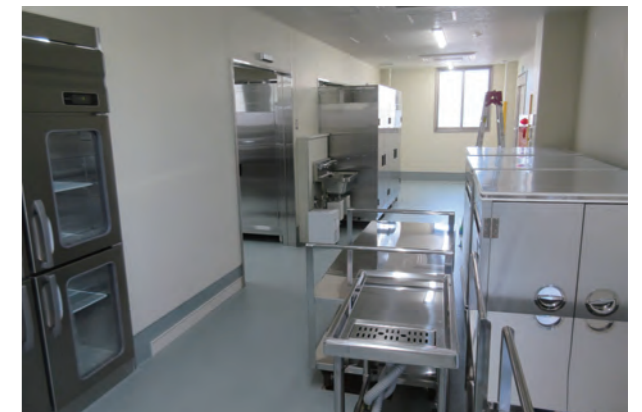
配膳室 出来上がった給食をコンテナに入れて教室へ運ぶため、また教室から返ってきたコンテナ等を一時的に保管する部屋です。
