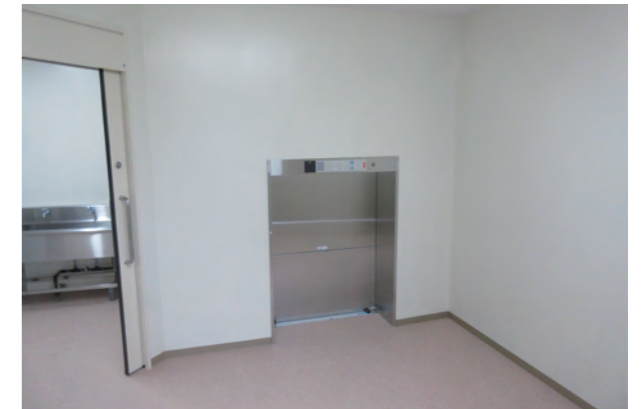
ダムウェーター(小荷物専用昇降機) 給食の入ったコンテナを校舎の2階から3階まで運ぶための小荷物専用の昇降機です。
