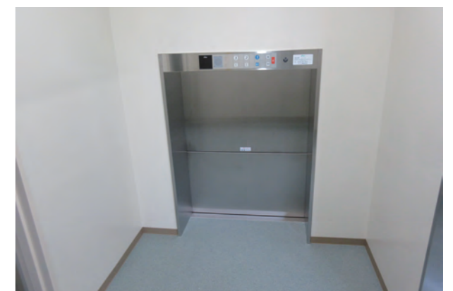
ダムウェーター（小荷物専用昇降機） 給食の入ったコンテナを校舎の2階から3階まで運ぶための小荷物専用の昇降機です。
