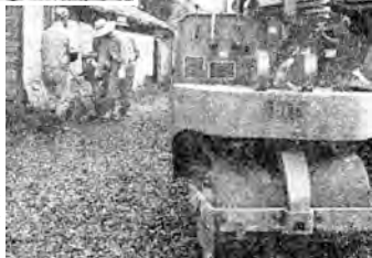
▶ローラーによる転圧（東井上）
