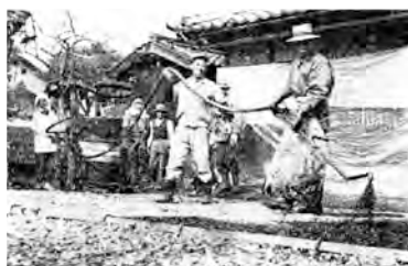
◀アスファルトの散布（東井上）
