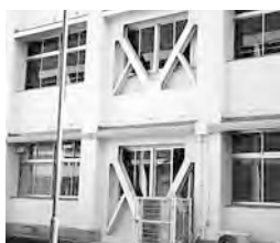
▲耐震工事が行われた北小学校南館
