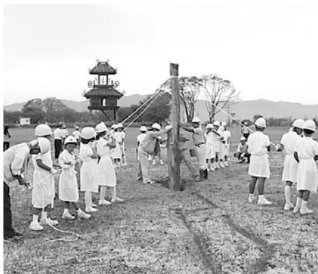
▲力を合わせて穴の中に柱を立てる
