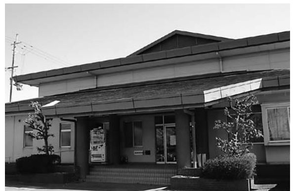
やすらぎ体育館の外観
