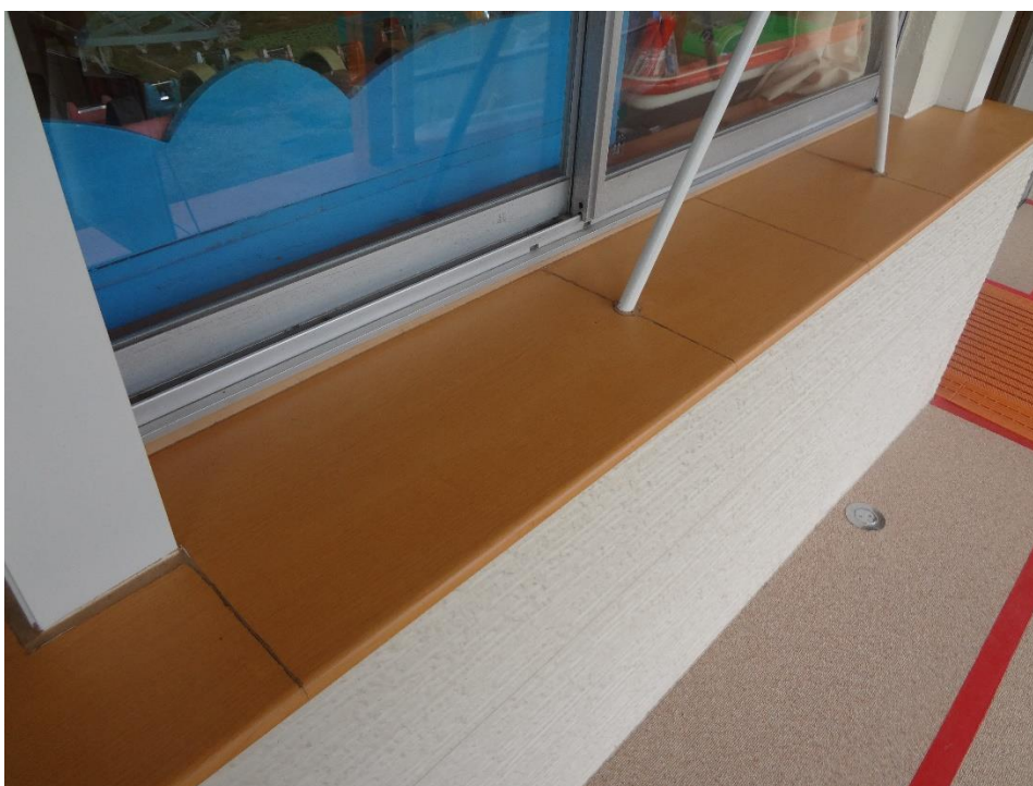
(ブレース増設)
