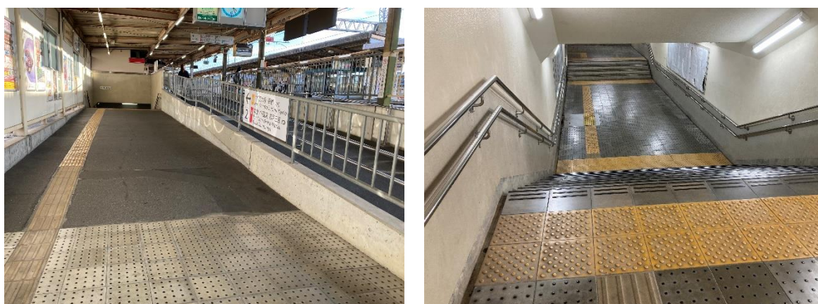
写真 4 地下通路の状況
