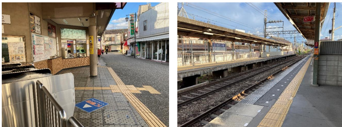
写真 3 田原本駅の状況（左：東口の改札前の状況、右：ホームの状況）
