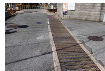
現況の道路西側の舗装・側溝蓋
