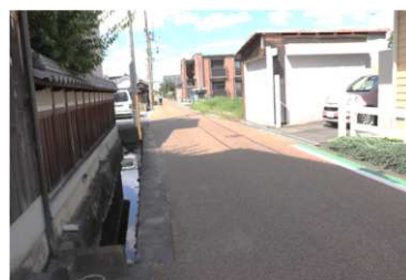
現況の道路の水路部
