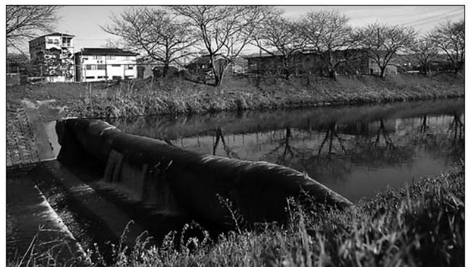
▲八尾地区・金剛寺地区の大型井堰の改修を行います
