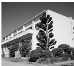
▲耐震工事が行われた南小学校南館
